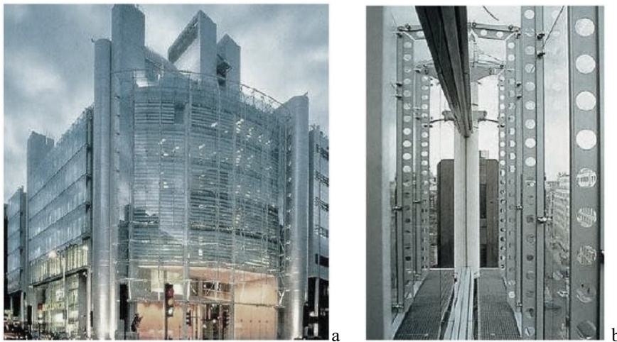
Figs.13 a,b: Le 'Helicon' Finsbury Pavement, London 2001(UK) architecte Sheppard Robson, vue sur l'extérieur (a), vue de la cavité (b). Source: V. Yellamraju, 2004)
